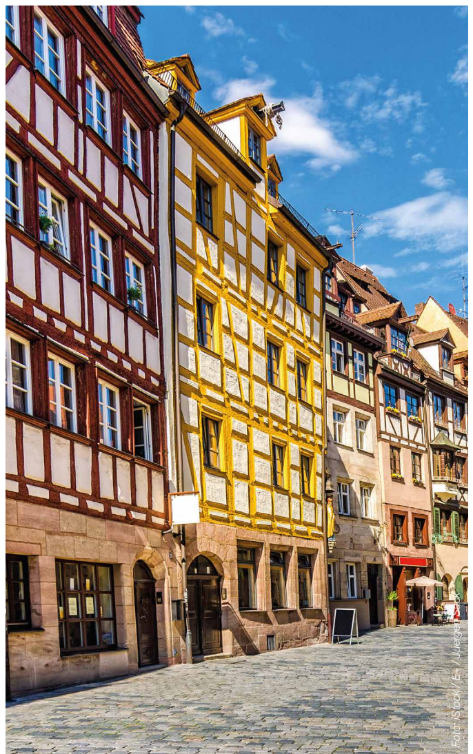
Fachwerkhäuser, eng beieinander – hier sprechen gleich zwei Gründe gegen eine Außen- und für eine Innendämmung
